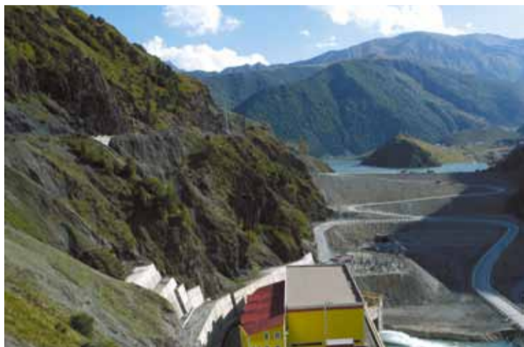
С 18 сентября Головная ГЭС Зарамагского каскада обеспечивает электроэнергией стройплощадку Зарамагской ГЭС-1.
