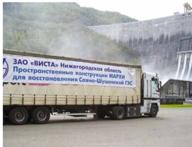
11 сентября на станцию из Нижегородской области прибыли первые две машины с 40 тоннами важного груза – металлических конструкций для восстановления шатра машинного зала.
