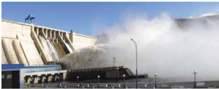
Испытания подтвердили, что уникальный водосброс Бурейской ГЭС можно использовать для пропуска серьезных паводков.
