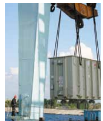
До 2013 года на Саратовской ГЭС заменят все пять трансформаторов.
