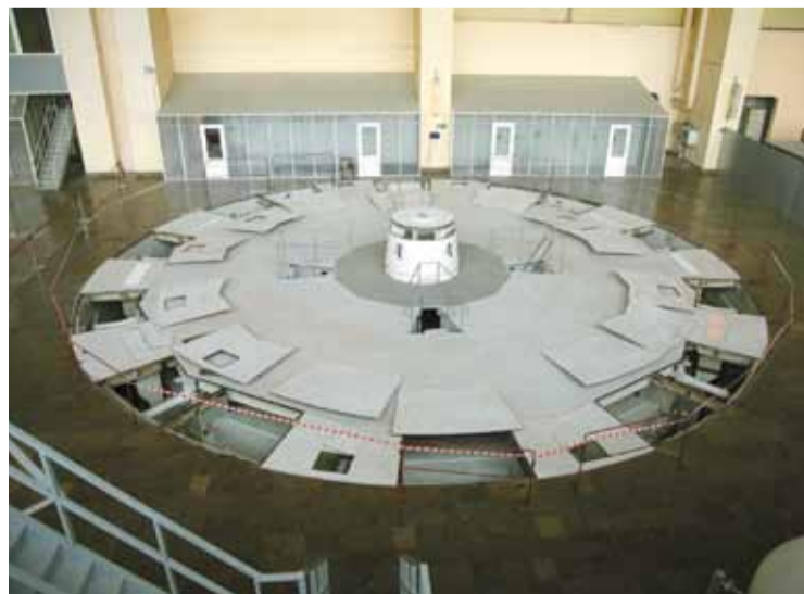
30 июня четвертый гидроагрегат был пущен на холостом ходу.
