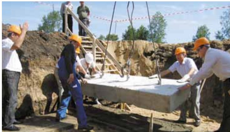
На строительство современных расчетных центров для абонентов Шумерли и села Батырево ЧЭСК выделит 100 млн рублей.
