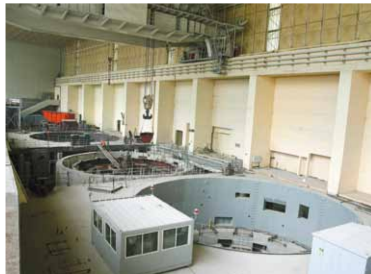
В зоне 7-го и 9-го гидроагрегатов восстановлено перекрытие на отметке 327 метров.
