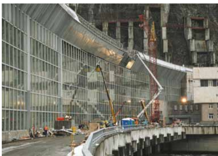
Разрушенные конструкции машинного зала были отремонтированы в рекордные сроки.
