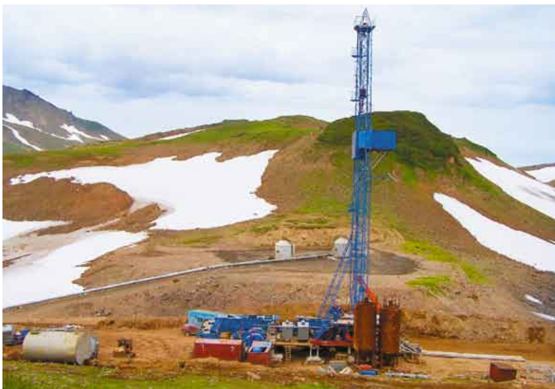
Знаковым событием 2008 года для Геотерма стало завершение бурения новой скважины и ввод ее в производственный цикл.
