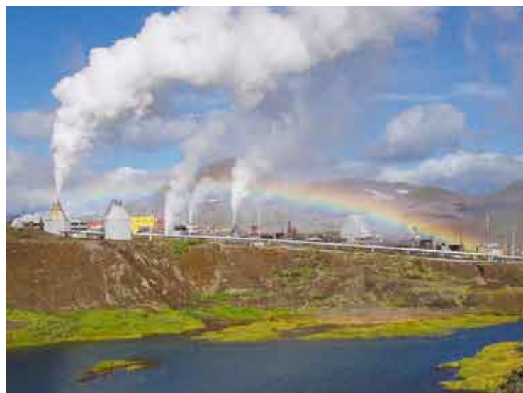
Сейчас в работе Мутновских геотермальных станций задействованы 33 скважины.
