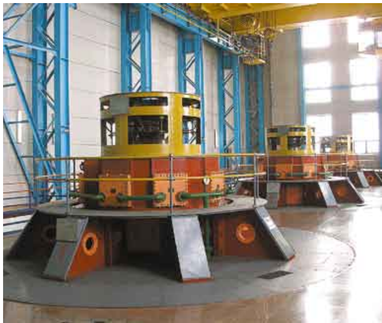
На Аушигерской ГЭС завершился капитальный ремонт гидроагрегата №1.
