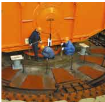
На гидроагрегате №2 Саяно-Шушенской ГЭС впервые заменили колонку управления в системе регулирования.
